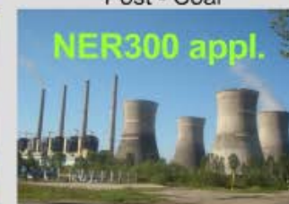
CET - Getica (Turceni) Romania - >250MWe Chilled Ammonia - Lignite
