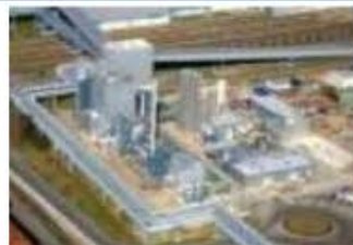
Vattenfall Schwarze Pumpe Germany - 30 MWth Oxy - Lignite
