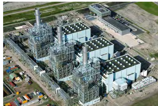
Magnum Power Plant; Photo Vattenfall
